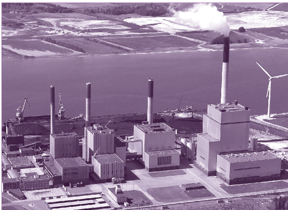
Figure 4 • Nordjyllandsværket general view
